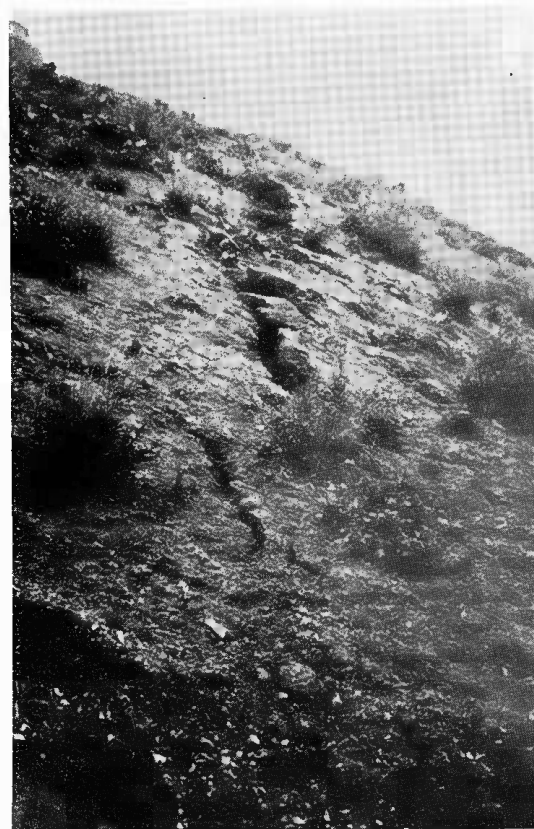
FIGURE 16. — Crevasses, à rejet modeste, dans la masse d'argile à silex effondrée au Sud. Noter que l'effondrement s'est fait en masse, en respectant la végétation, restée en place. Vue prise au sol, le 20.9.82.
