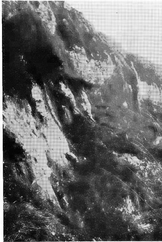
FIGURE 10. — Surface de décollement à la limite du talus glissé et du talus intact, au Nord. Prise de vue légèrement oblique sur cette surface, orientée vers le Sud-Est. Au sol, le 9.10.82 après-midi.
