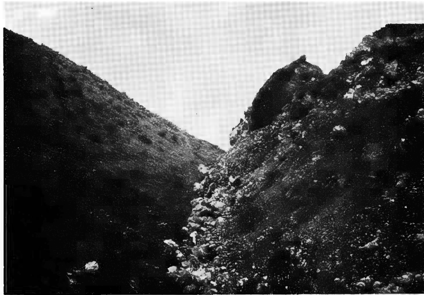
FIGURE 15. — Jonction entre la masse d'argile à silex effondrée au Sud, et le revers oriental de la crête. Vue prise vers le Sud, au sol, le 20.9.82.
