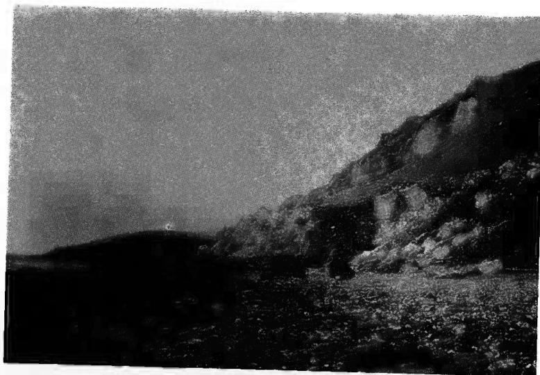
FIGURE 12. — Vue prise du Sud, du littoral : on ne voit que la « coulée » résultant de l'affaissement de la décharge sud : son profil convexe apparaît nettement. 20.9.82.
