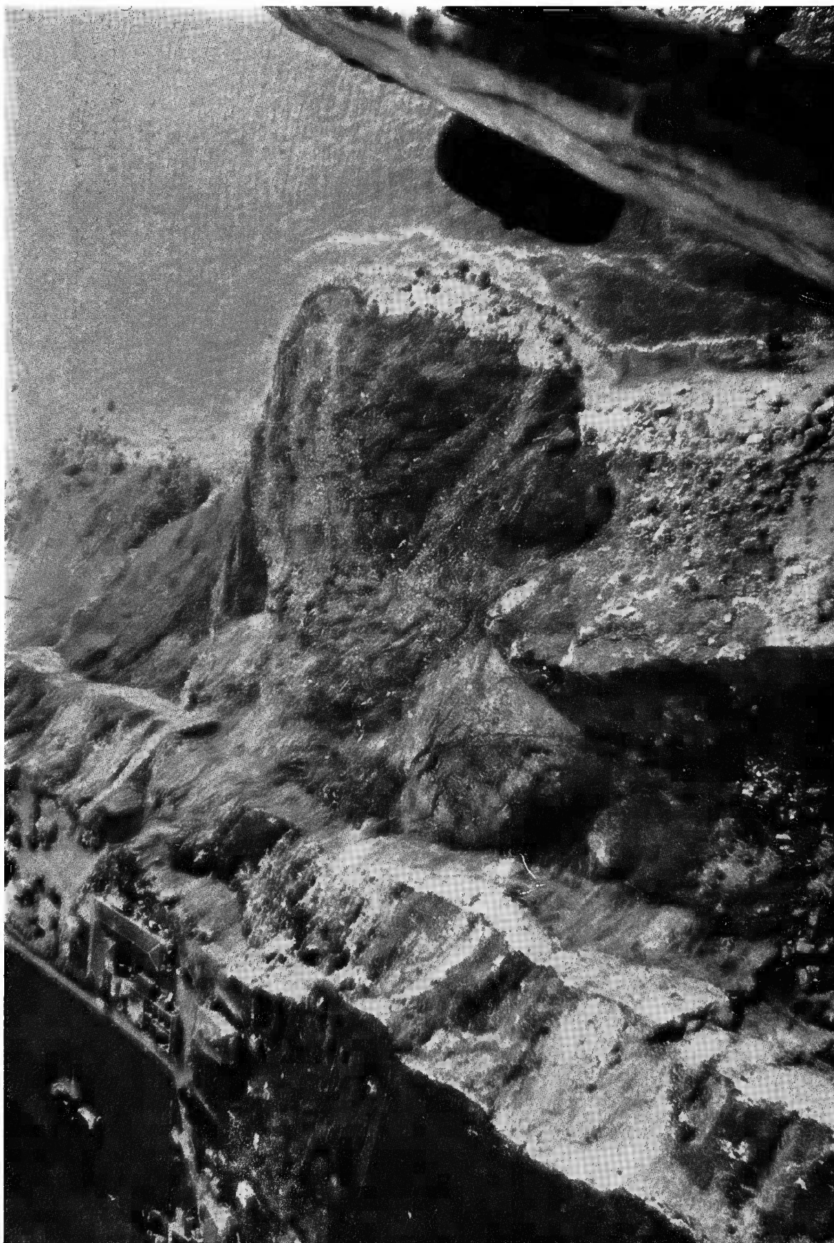
FIGURE 17. — Vue d'ensemble du glissement ; partie sud. Vue prise d'hélicoptère, suuverticale, le 10.9.82, après-midi. Les différentes unités décrites dans le texte sont localisées sur le schéma interprétatif du calque.
