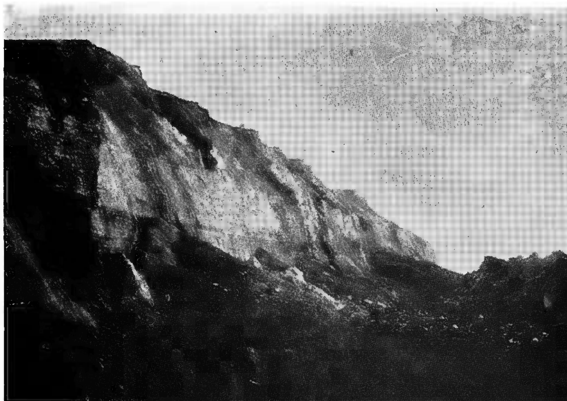
FIGURE 5. — Dépression formée lors du glissement vers la mer du talus d'éboulis. A gauche, la falaise ; à droite, la crête (voir fig. 6). Au fond, le «tas» d'argile à silex (paragraphe 3.5). Vue prise vers le Sud, au sol, le 20.9.82.
